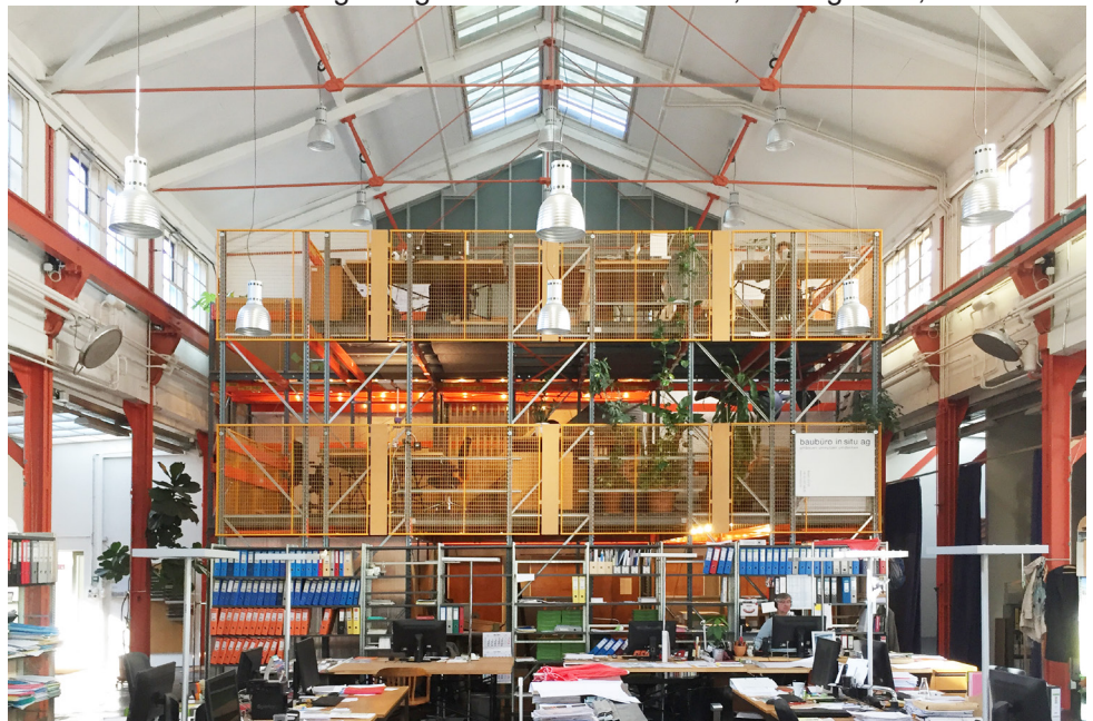
Büroumbau - Aufstockung aus gebrauchten Materialien, selbstgebaut, 2018
