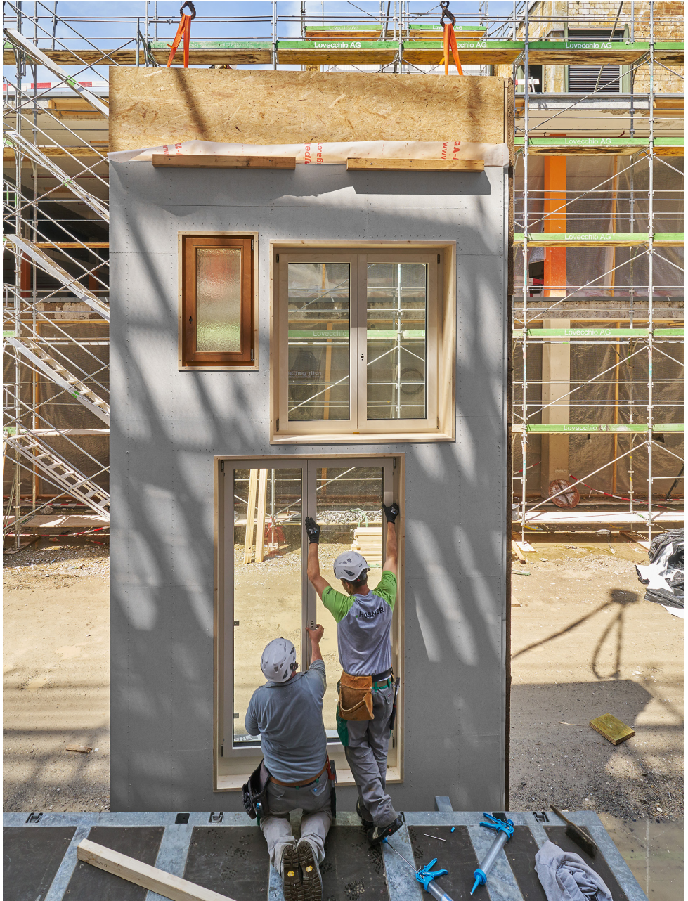
Montage der vorfabrizierten, bis zu 9 Meter hohen Fassadenelemente
