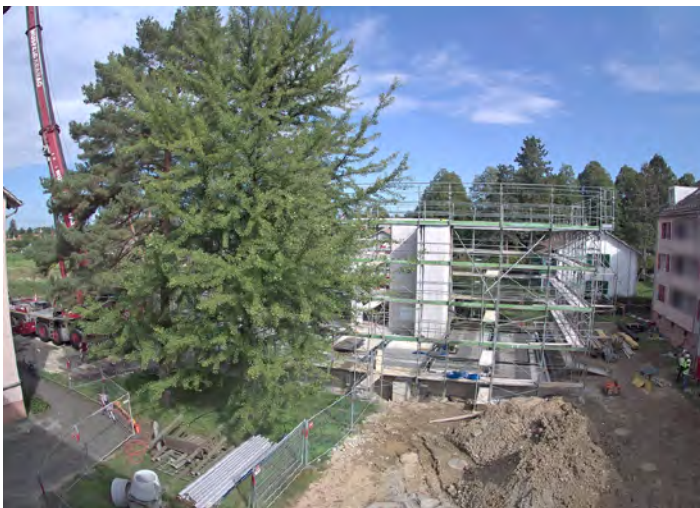
Baustelle, Stand 3. September 2020
