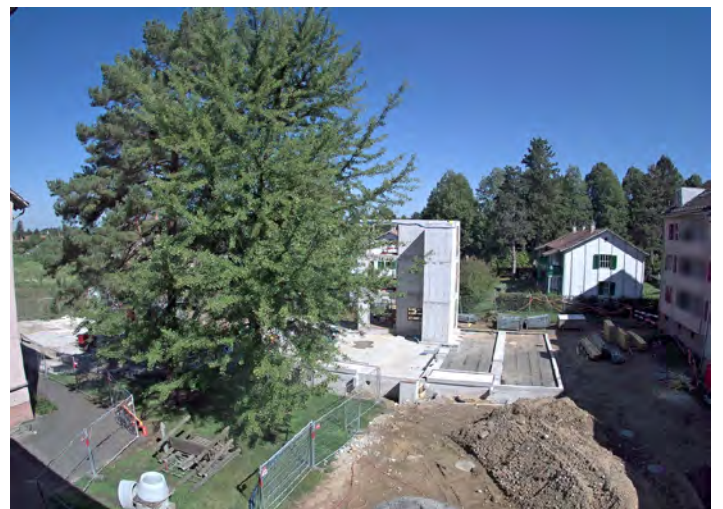
Baustelle, Stand Ende August 2020
