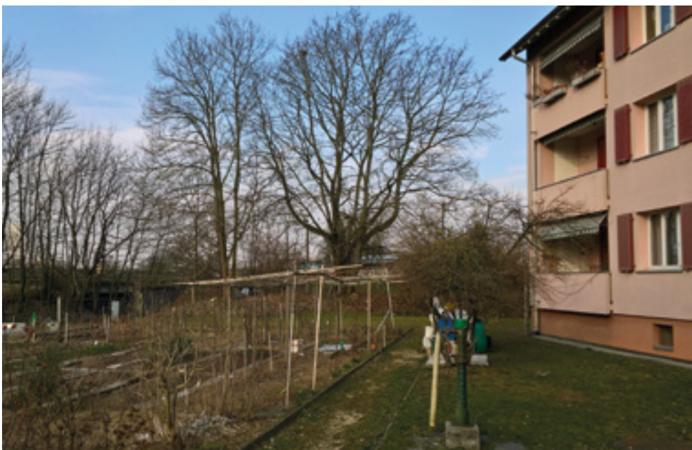
Teilfassade Hirtenweg 28 von Süden Richtung Westen (Aufnahme 2019)
